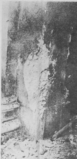
La colonna di piazza Loggia sbriciolata dopo lo scoppio: la bomba era stata posta nel cratere dei rifiuti appoggiato alla stessa strada.
