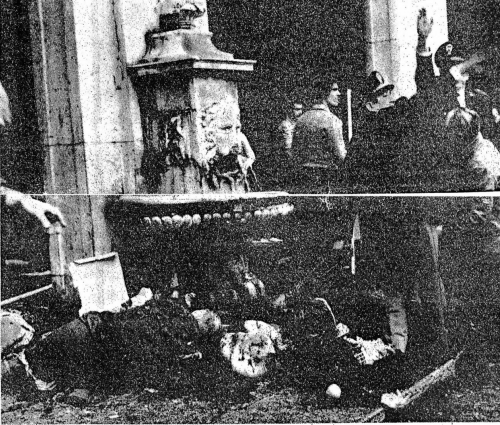
BRESCIA. - Accanto alla fontana è esplosa la bomba semiautomatica e trapieta. A terra alcuni corpi incombenti. (Telefoto AP)
